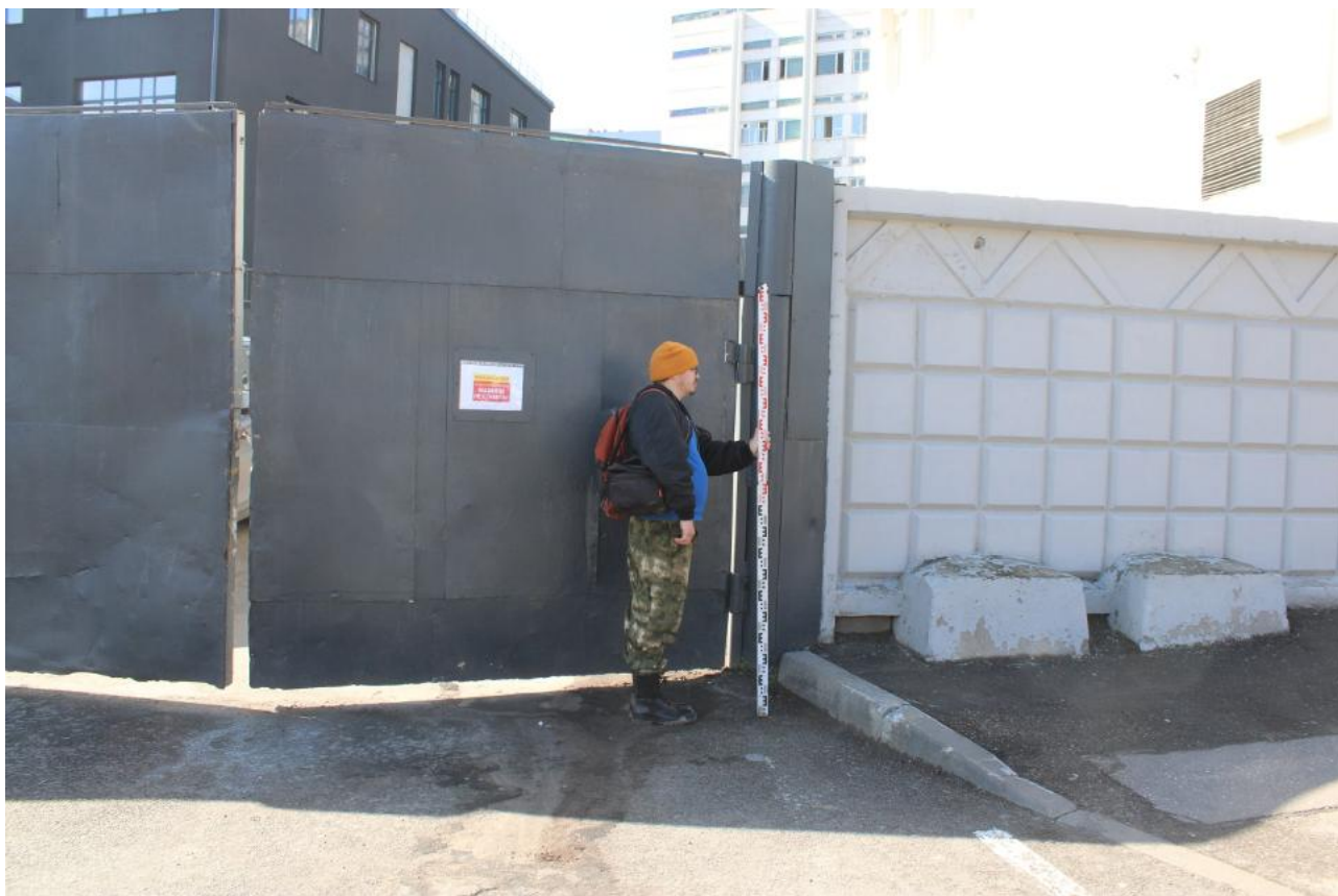
Илл. 25. Общий вид земельных участков, отведенных под расположение проектируемого объекта: «Квартальные тепловые сети от НТЦ, 2 очередь (ТК-236-1)», адрес (местоположение): г. Нижний Новгород, Нижегородский район, от ТК-236-1 у д.32 Д по ул. Варварская до т. в 36 м на СЗ от С угла д.32Д по ул. Варварская на границе ЗУ 52:18:0060075:6». Точка фотофиксации 1. Вид с севера.
