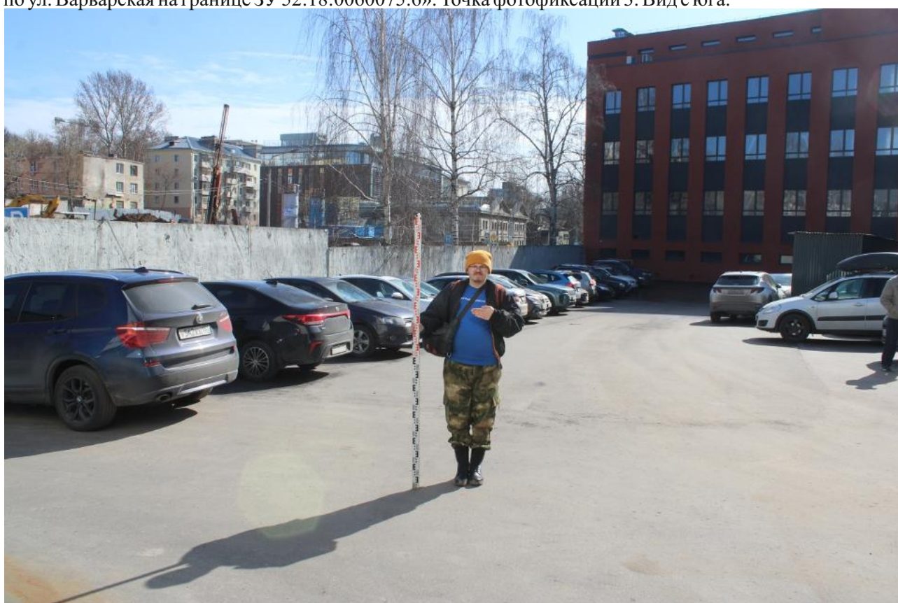
Илл.32. Общий вид земельных участков, отведенных под расположение проектируемого объекта: «Квартальные тепловые сети от НТЦ, 2 очередь (ТК-236-1)», адрес (местоположение): г. Нижний Новгород, Нижегородский район, от ТК-236-1 у д.32 Д по ул. Варварская до т. в 36 м на СЗ от С угла д.32Д по ул. Варварская на границе ЗУ 52:18:0060075:6». Точка фотофиксации 3. Вид с запада.
