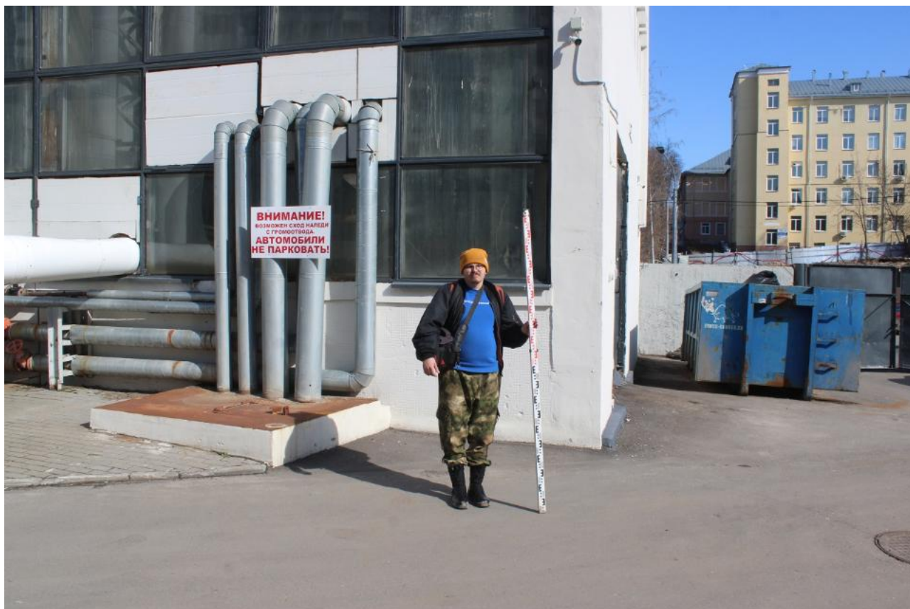
Илл. 27. Общий вид земельных участков, отведенных под расположение проектируемого объекта: «Квартальные тепловые сети от НТЦ, 2 очередь (ТК-236-1)», адрес (местоположение): г. Нижний Новгород, Нижегородский район, от ТК-236-1 у д.32 Д по ул. Варварская до т. в 36 м на СЗ от С угла д.32Д по ул. Варварская на границе ЗУ 52:18:0060075:6». Точка фотофиксации 2. Вид с юга.
