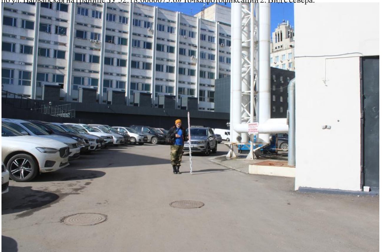
Илл. 30. Общий вид земельных участков, отведенных под расположение проектируемого объекта: «Квартальные тепловые сети от НТЦ, 2 очередь (ТК-236-1)», адрес (местоположение): г. Нижний Новгород, Нижегородский район, от ТК-236-1 у д.32 Д по ул. Варварская до т. в 36 м на СЗ от С угла д.32Д по ул. Варварская на границе ЗУ 52:18:0060075:6» Точка фотофиксации 2. Вид с востока.
